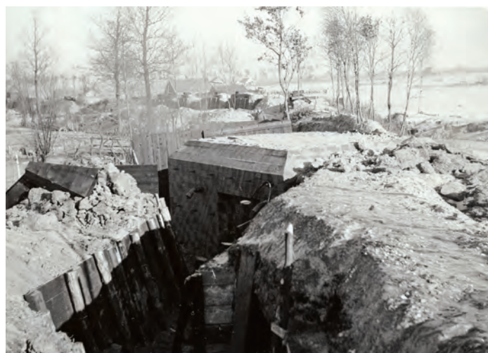
Loopgravenstelsel met betonnen kazemat, kort na de mobilisatie van 1939 aangelegd in de frontlijn.
