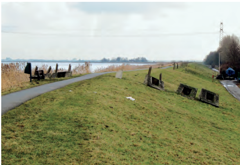
Antitankversperringen van spoorstaven in beton uit 1939-1940 ter afsluiting van de dijkbermen ten oosten van Spakenburg.
