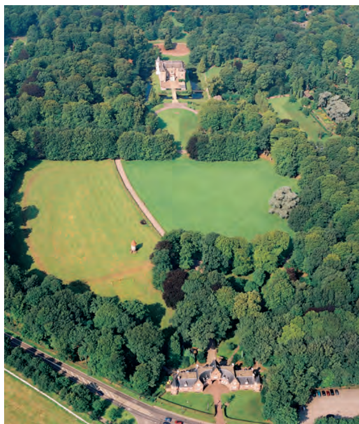
Huis Doorn met op de voorgrond het poortgebouw uit 1920 in de nieuwe as van het huis.
