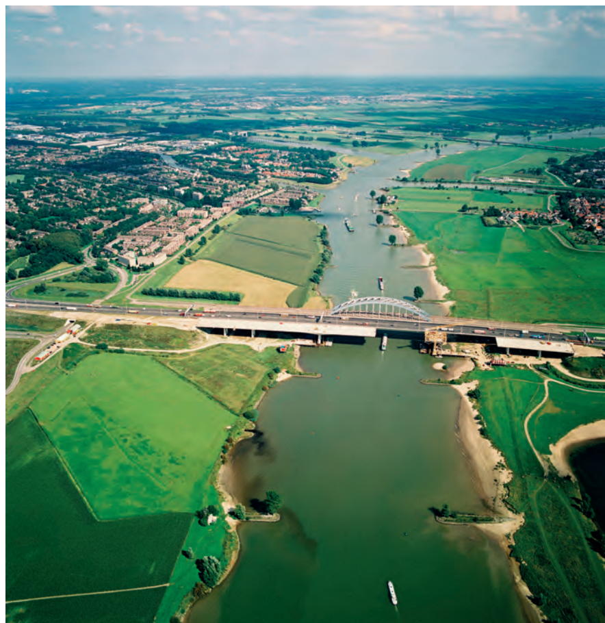
De Lek in oostelijke richting met zicht op de boogbrug uit 1936, oorspronkelijk deel uitmakend van een serie grote rivierbruggen uit het Rijkswegenplan van 1927. Luchtfoto van september 2002.
