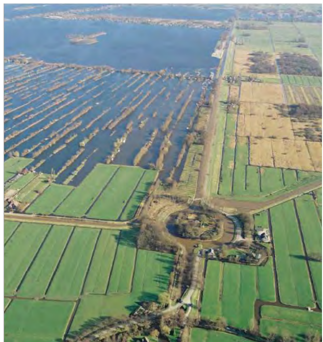
Fort bij Tienhoven ter bewaking van het Tienhovense kanaal. Links de Loosdrechtse plassen met trekgraten en legkokers. Rechts de droogmakerij Bethunepolder.
