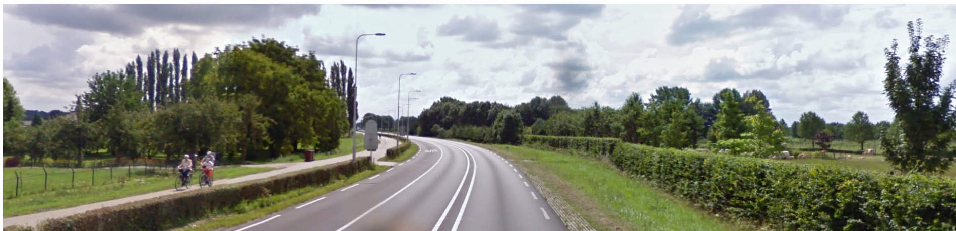
3 - N229 / Werkhovenseweg; de provinciale weg is gedeeltelijk aangelegd op het bestaande tracé van de Werkhovenseweg. De weg heeft een redelijk breed profiel en heeft geen begeleidend beplanting
