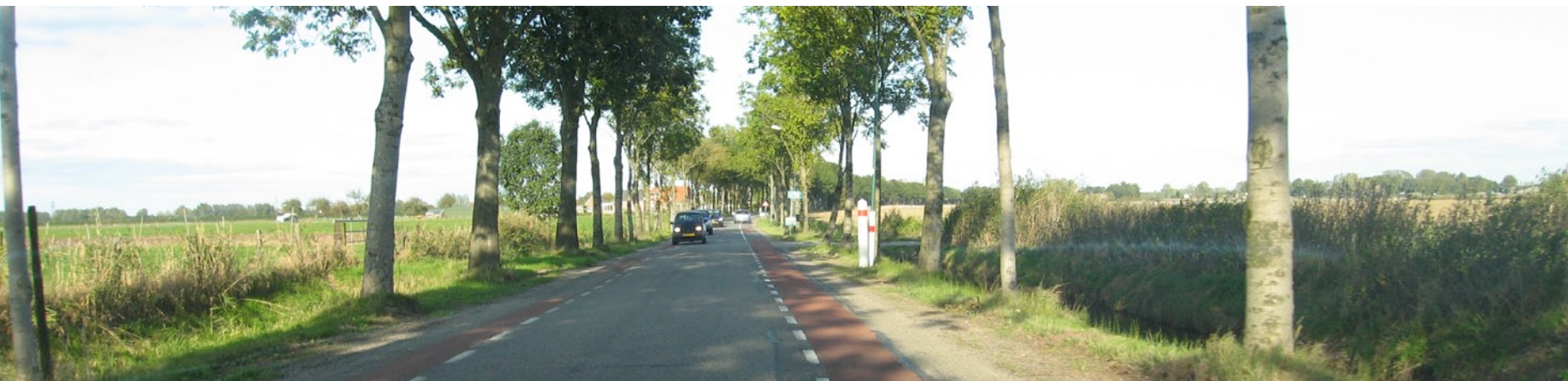
4 - N410 / Kruisweg Houtenseweg; cultuurhistorisch waardevolle weg met ter weerszijde boerderijen en een rij boombeplanting .
