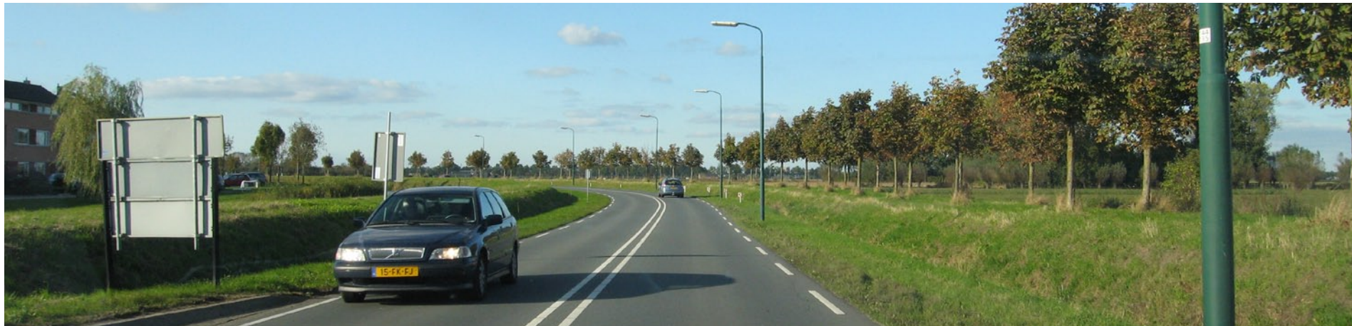
1 - Rondweg Houten; geen directe toegang tot woonbebouwing en de grens van de bebouwing van Houten vormend/volgend. De oostkant van de weg is omzoomd met een dubbele boombeplanting.
