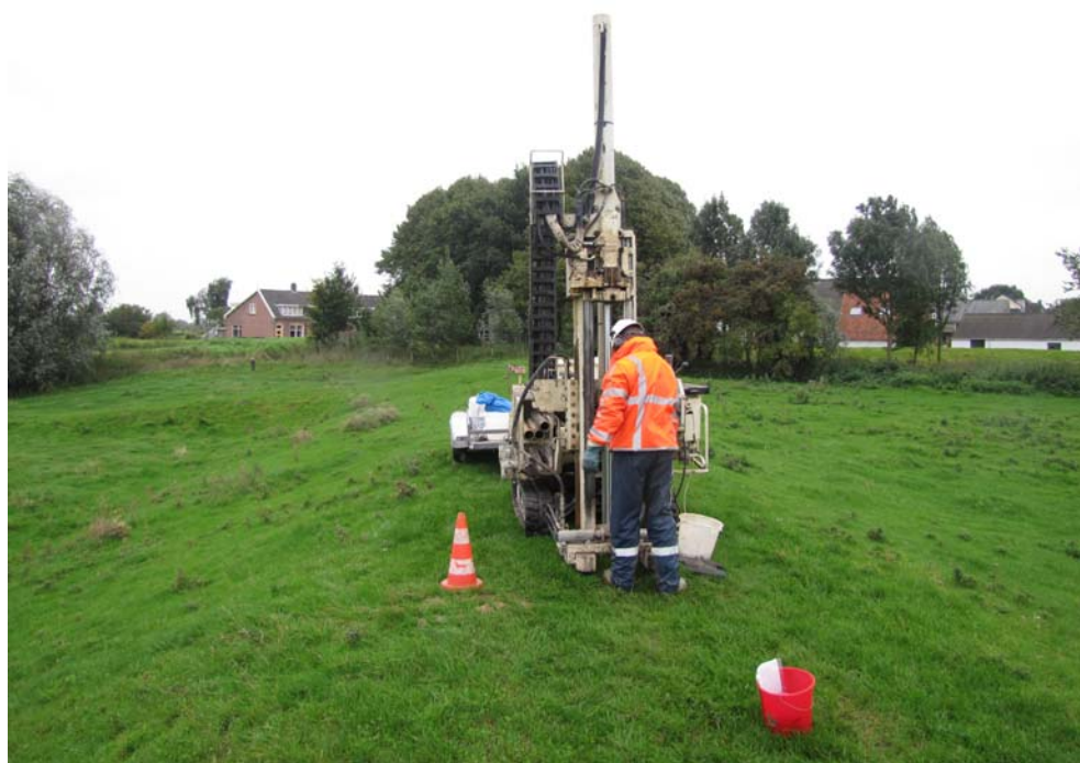
Figuur 10: Mechanische boringen in de Mijnsheeren waard
