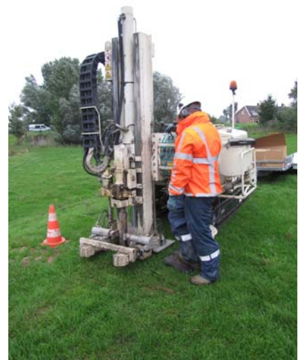
Figuur 5: Geoprobe mechanische boorinstallatie aan het werk
