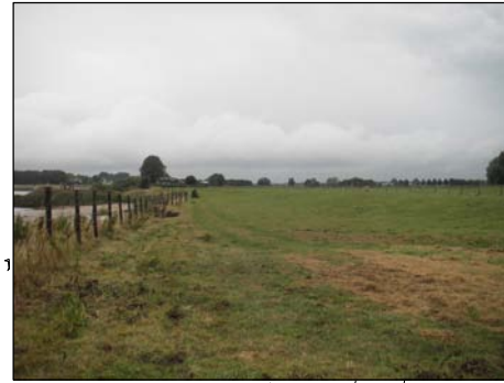
Hek langs oever, op strand metaal afval, steil talud
