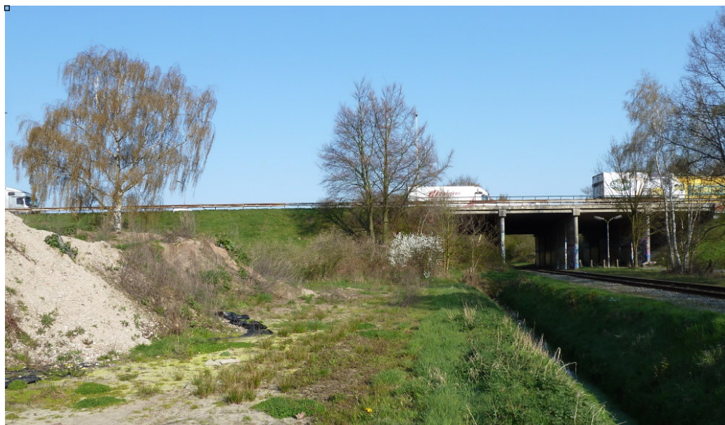
Viaduct PON-lijn, bij A28 ten oosten van de Arnhemseweg.
