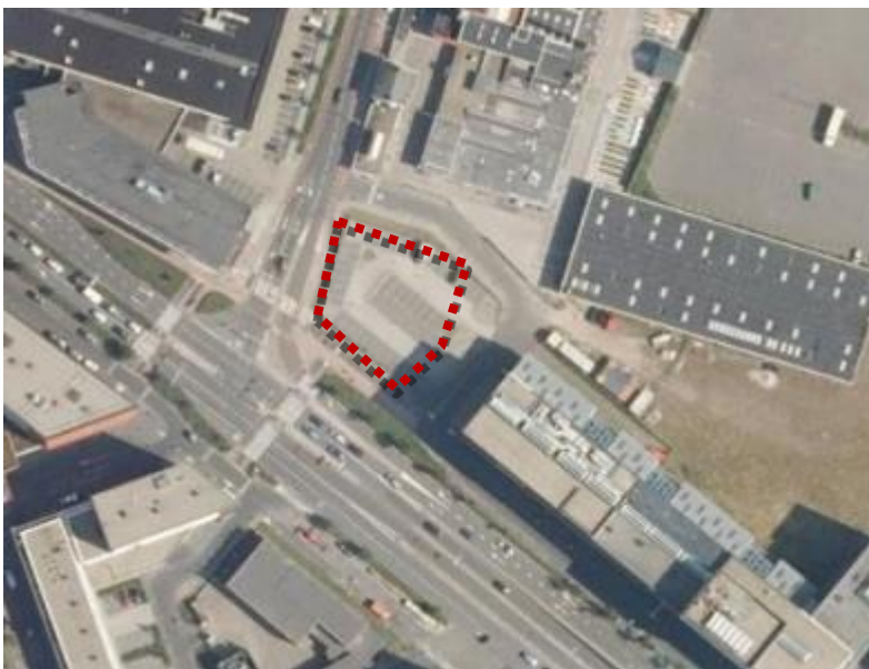
afbeelding 15: Luchtfoto onbebouwd perceel in bestemmingsplan 'Bedrijventerrein e.o. en snelwegen'
