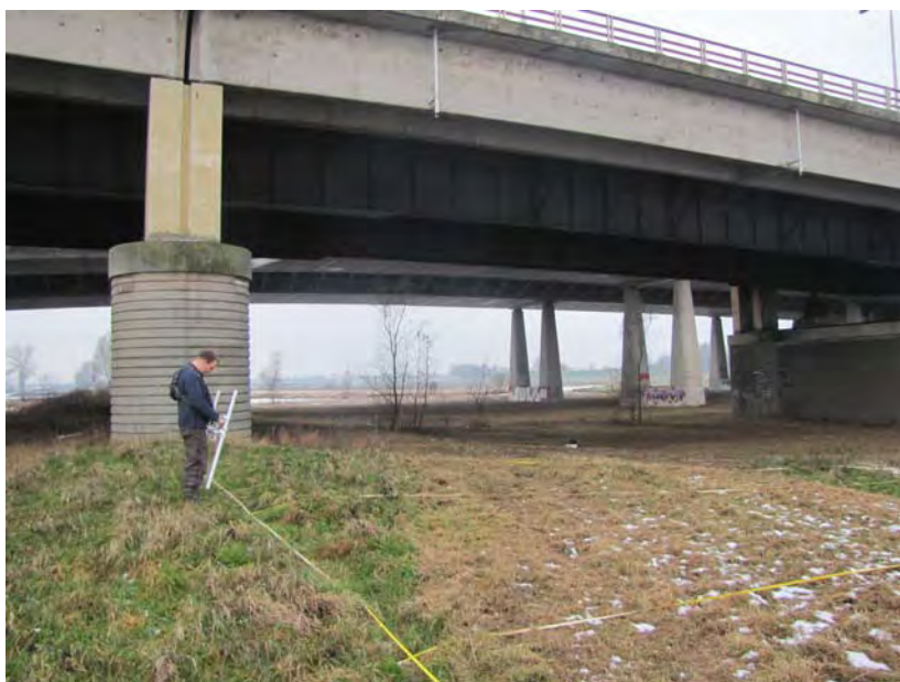
Figuur 6: Op het oostelijke terreindeel ligt een deel van het meetblok direct naast brugpijlers. De aanwezigheid hierin van wapeningsmetaal en de aanwezigheid van de metalen liggers van het brugdek e.d. vertekent de meetresultaten.
