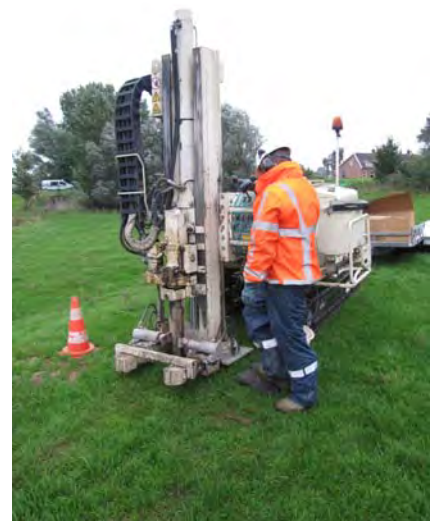
Figuur 5: Geoprobe mechanische boorinstallatie aan het werk
