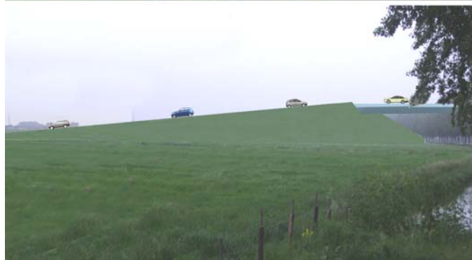
Figuur 7.3 Zicht (2) vanaf de Kanaaldijk richting het zuidoosten
