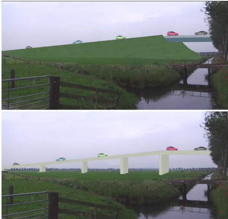
Figuur 7.14 Variant Meerpaal/ Nieuwe brug, in plaats van een talud een open brugconstructie
