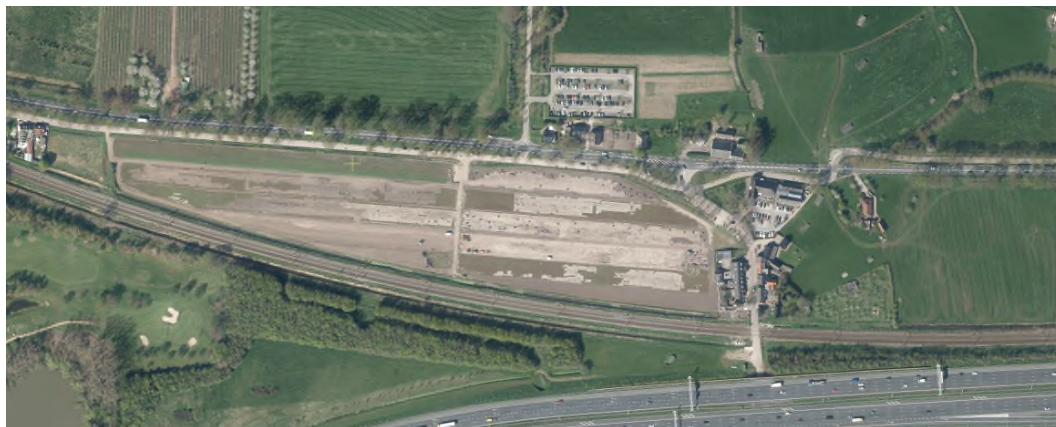
Figuur 1-4. Sedumveld en oversteek welke onderdeel uitmaken van de herinrichting.
