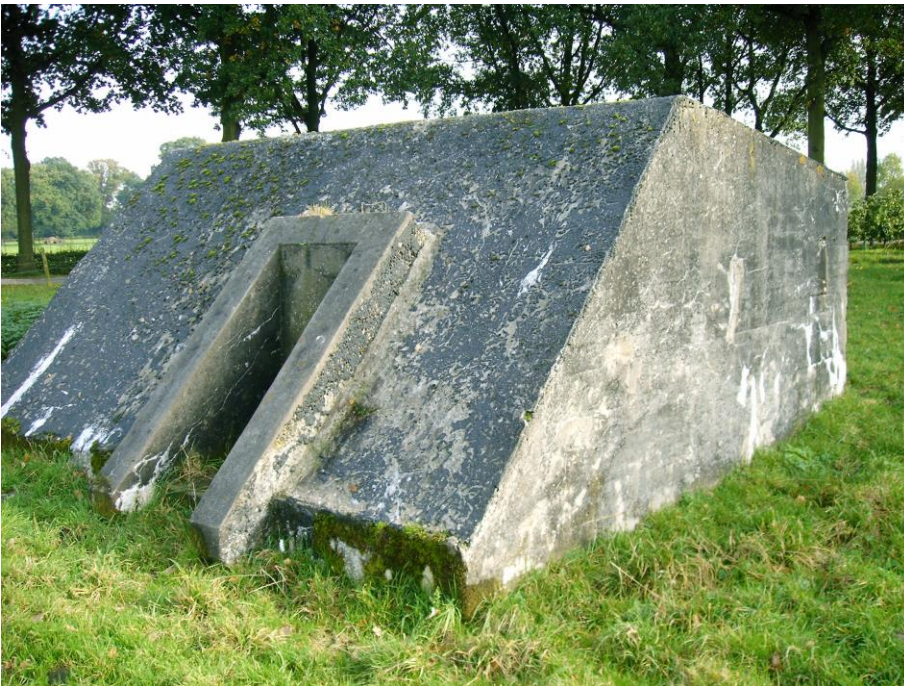
Betonnen groepsschuilplaats Type 11918/1
