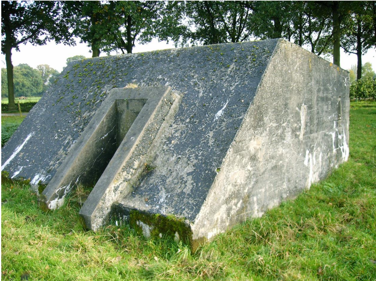
Betonnen groepsschuilplaats Type 11918/1
