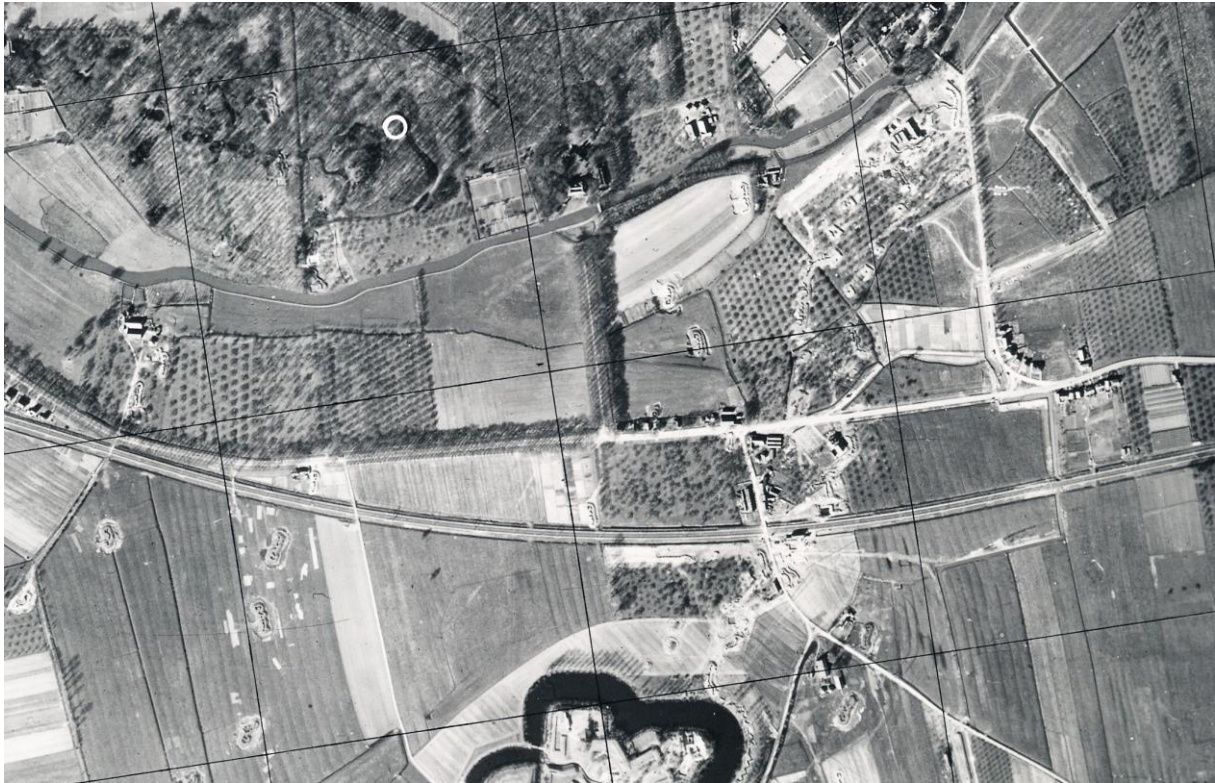
Tussenstelling Rijnauwen-Vechten van 1918. Goed zijn de groepsnesten en loopgraven te zien die in 1939-1940 rond de betonnen schuilplaatsen zijn uitgegraven. Links de Stelling Utrecht uit 1939-1940 met een serie nu verdwenen groepsnesten ter weerszijden van de A2. Luchtfoto uit 1940
