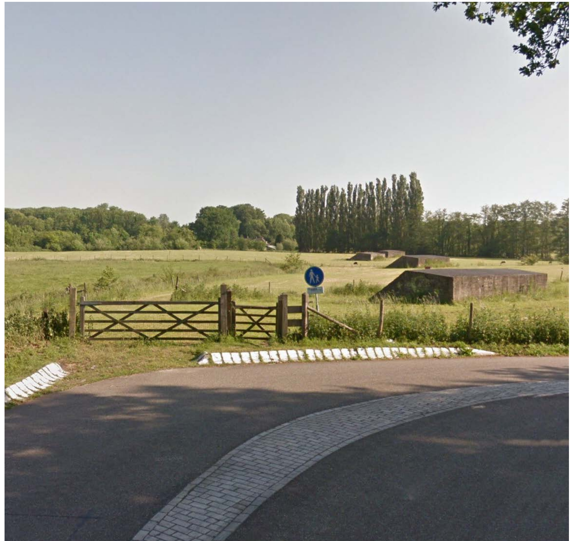
Figuur 9 Bunkerperceel en het begin van het bunkerpad (Nieuwe Hollandse Waterlinie)
