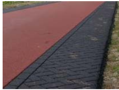
Rabatstrook: asfalt met streetprint
